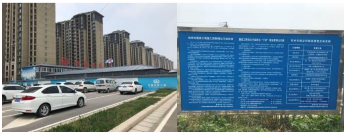
苑陵路站施工场地
