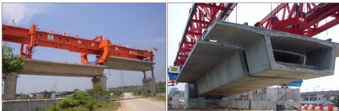
整孔预制吊装施工
